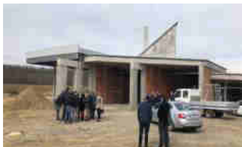
Slika 13. Radovi na oproštajnoj građevini Kušanec
