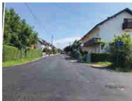
Slika 7. Asfaltiranje Školske ulice – Velika Mlaka
