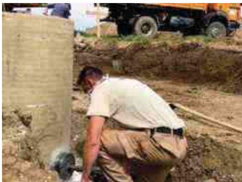
Slika 8. Izvođenje radova u PJ Građenje
