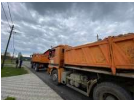
Slika 7. Izvođenje radova u PJ Građenje
