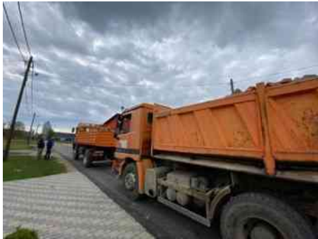
Slika 7. Izvođenje radova u PJ Građenje
